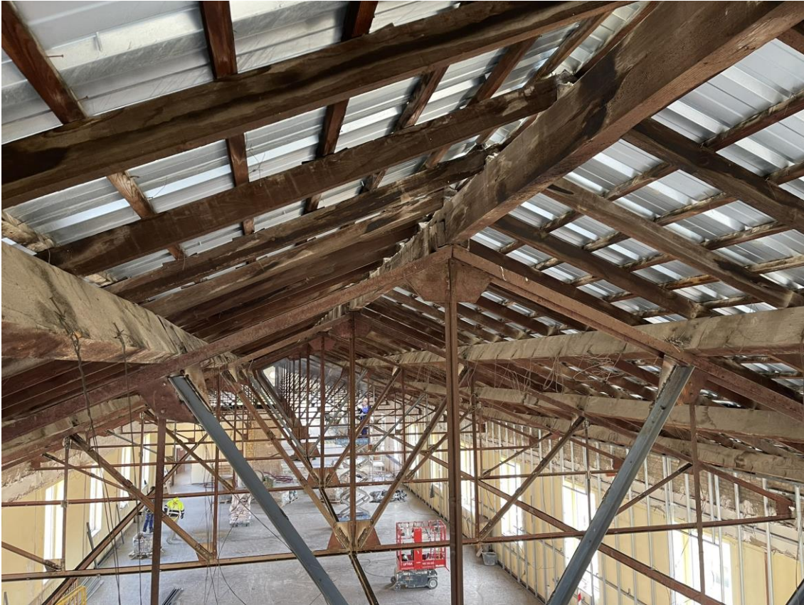
Imagen 1. Vista de una cubierta de mobila.
